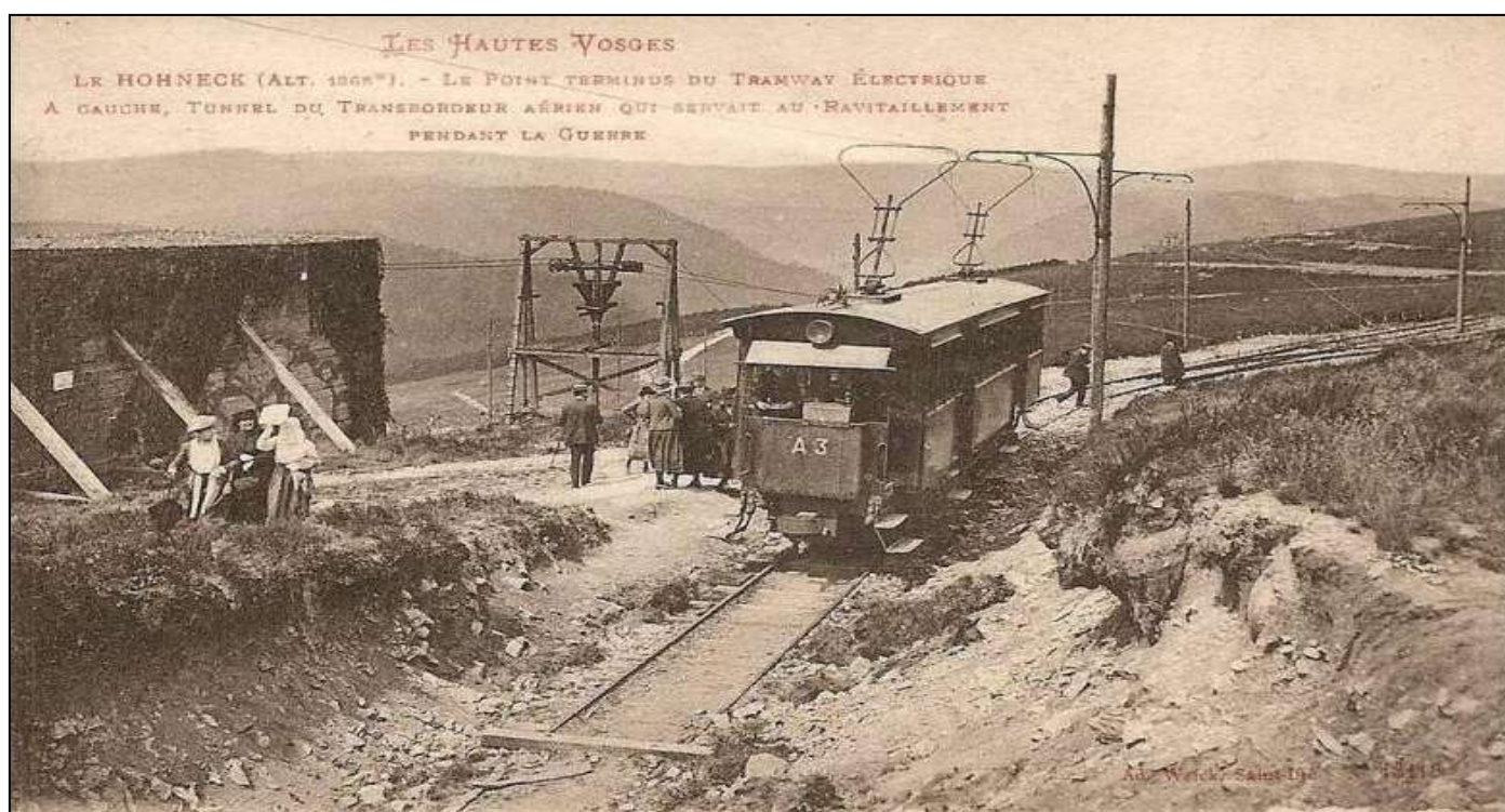
L'entrée de la station souterraine du transporteur au Hohneck, à gauche de la ligne de tramway. (coll. pr.)
