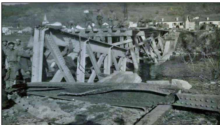
Pont de Thiéfosse, sur la Moselotte, détruit par les allemands, construction d'un pont provisoire en bois par l'armée
